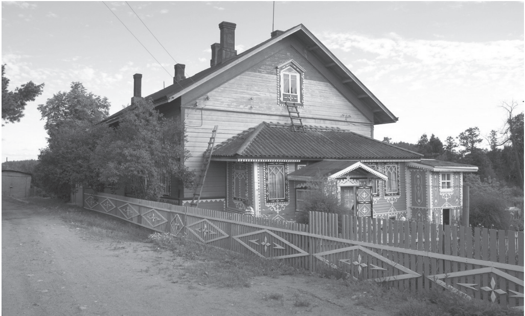
Kuva 3. Suomalaisen ja venäläisen rakennustaiteen vuoropuhelu: entisen maamiesopiston 1800-luvun lopulla rakennettu talo – presidentti Lauri Relanderin lapsuudenkoti – on saanut helein värein maalatun, lehtisahaleikkauksin koristellun kuistin. Tyypillisiä muutoksia suomalaisaikaisissa taloissa on vinolaudoitus, koristeellinen lehtisahakuviointi, kirkkaat värit ja fortuskaikkunat. Kuva Juhani Seppovaara 2005.
