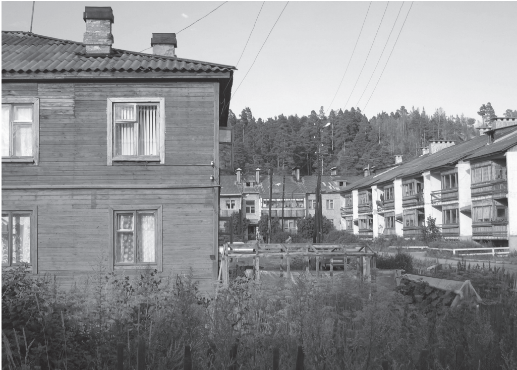
Kuva 2. 1970-luvun monenperheentalot Novaja-kadulla, entisellä Sepänkadulla, muodostavat uuden kerrostuman Kurkijoen kyläkuvasa. Betoni, laatat ja silikatiili ovat syrjäyttämässä puun rakennusmateriaalina. Kuva Netta Böök 2005.
